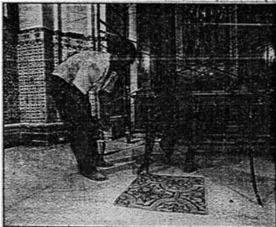
Exterior de la ermita y labores de pavimentación
