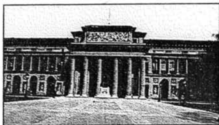
Fachada del Museo del Prado de Madrid, que guarda la mayor y mejor colección de obras de Goya
